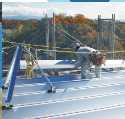
足場と折板上の相番作業(軒樋、水切取付等)従来は外部足場の親網へ安全帯を掛けていましたが、折板側の親網へ安全帯を掛けることにより、リスク低減
